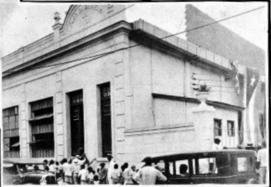
Edificio de la nueva fábrica de hielo "La Unión", perteneciente a la Sociedad de Detailistas de Santiago.
